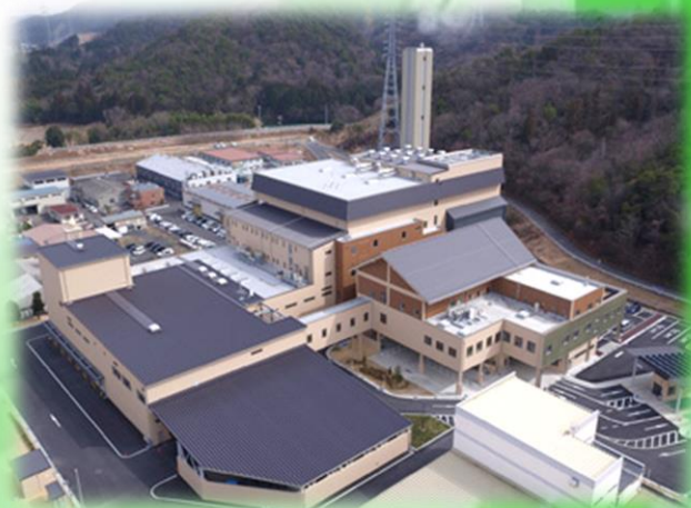
草津市立クリーンセンター (川崎重工業 HP より)
